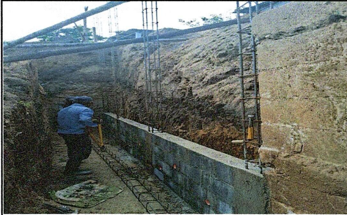
Foto 1: Inicio de remozamiento de muro de contención, extremo 1
