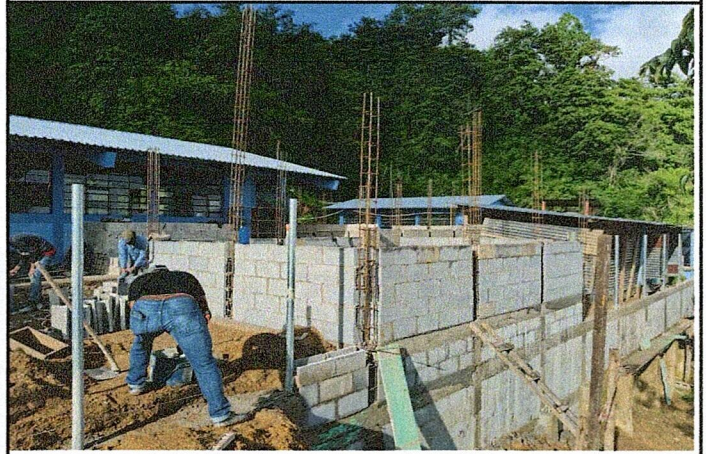
Foto 4: Avance de remozamiento de cocina e inicio de colocación de tubos para circular, parte frontal.
