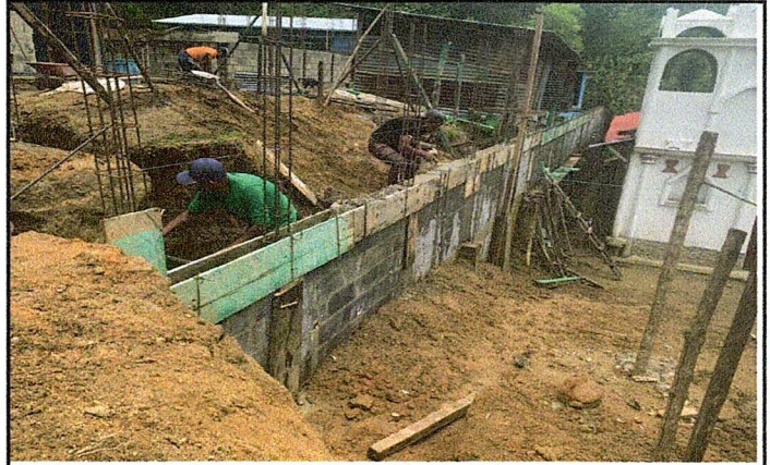
Foto 2: Avance de remozamiento de muro de contención ambos extremos y altura.
